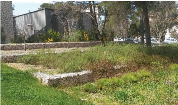
Type de gabions permettant de traiter les différences de dénivelé
